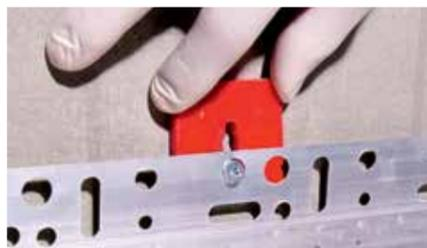
Выравнивание посадочного профиля Kalekim при помощи пластиковых колодок.
