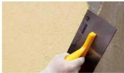
Декоративные покрытия, наносятся на поверхность при помощи мастерка. Толщина меняется от типа штукатурки.
