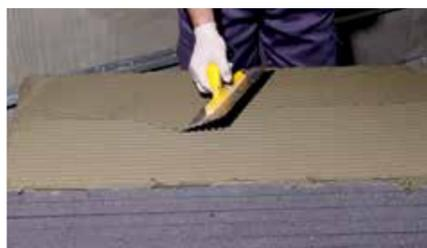
В зависимости от ровности поверхности необходимо пройтись скребковым шпателем (скребковый шпатель с зубцами 10x10 мм)
