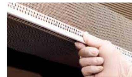
Установка карнизного углового ПВХ профиля с сеткой.
