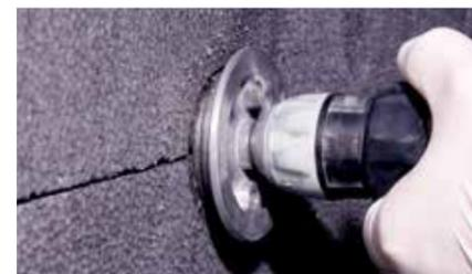
Для полной усадки головки дюбеля на приклеенную 24 часа назад теплоизоляционную плиту, проделывается отверстие для утопленной головки.
