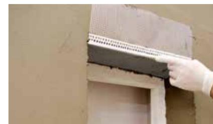
Установка на углы окон углового ПВХ профиля с сеткой.
