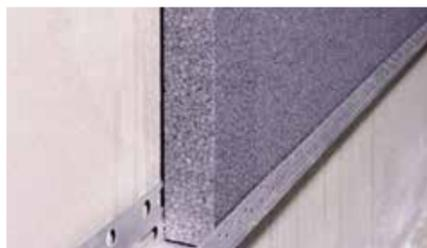
Установка теплоизоляционной плиты Kalekim EPS в посадочный профиль.
