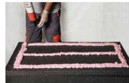
Нанесите полиуретановую пену по всему периметру краев плиты и по центру, параллельно края.
